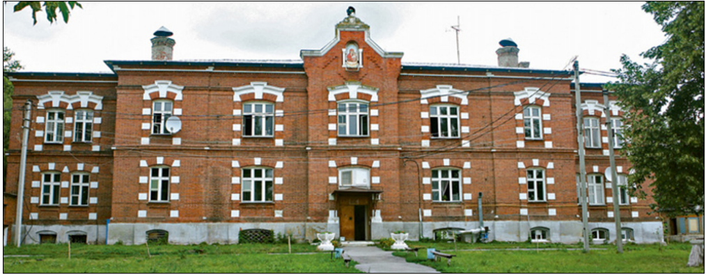
Современный вид больничного комплекса, построенного Гагариными в 1873 году в селе Сергиевском (нынешний Плавск).
